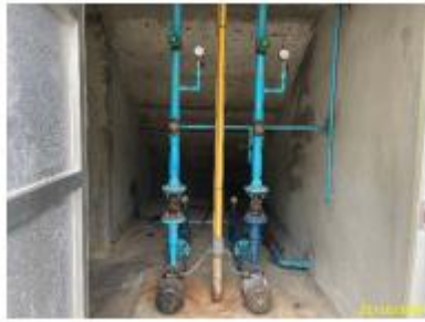
ปั๊ม และถังเก็บน้ำสำรองชั้นใต้ดิน อาคาร 4
